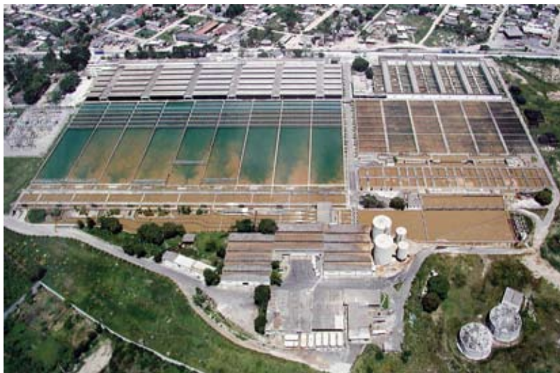
Estação de Tratamento de Águas do Guandu – ETA Guandu
